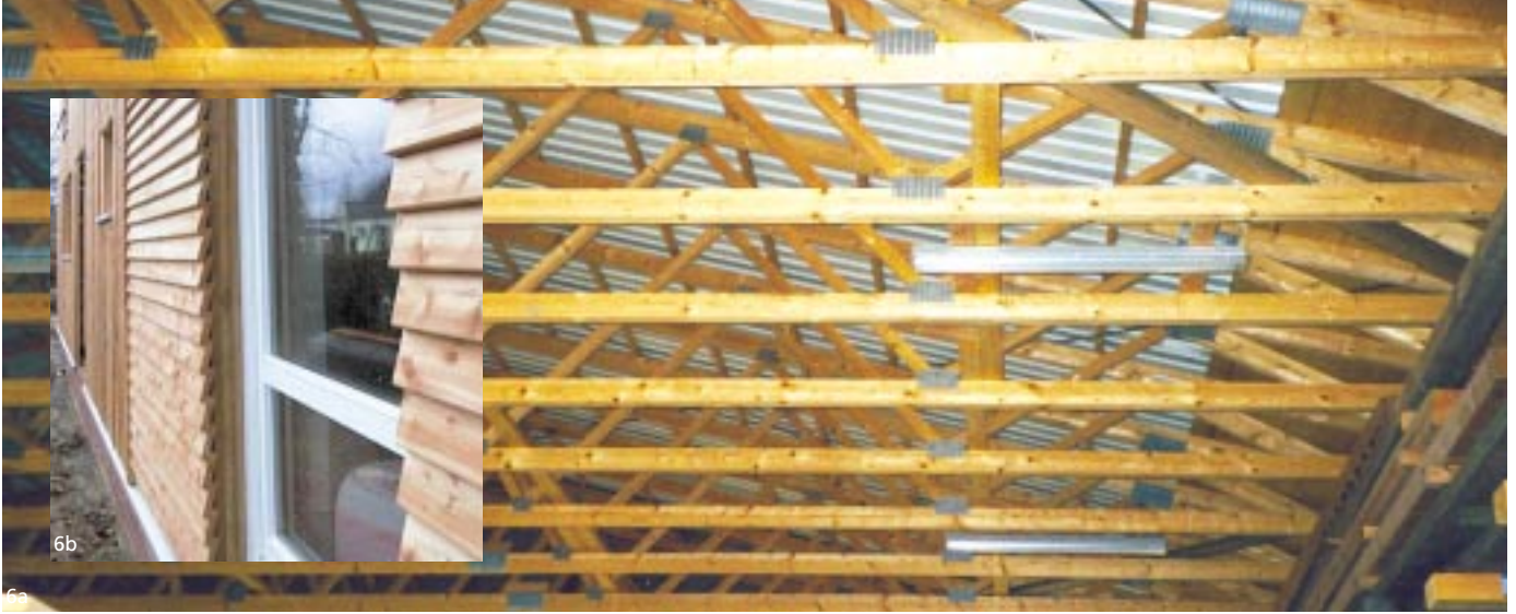
Abb. 6a, 6b: Holzverschalt Fassaden und Nagelplattenkonstruktionen im Dach-/Deckenbereich bieten für das Funktionsmodul „Hallenraum“ ästhetisch ansprechende und zugleich sehr wirtschaftliche Gestaltungsmöglichkeiten.
