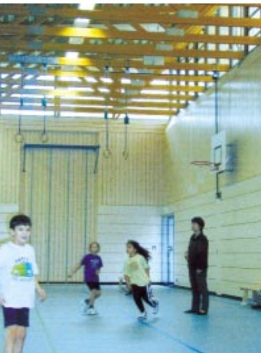
Abb. 22: Praxisbeispiel für den vorbildlichen Einsatz des Baustoffes Holz im Sportstättenbau: Nagelplattenbinder und holzverkleidete Innenwände einer Sporthalle im Kreis Bergstraße.
