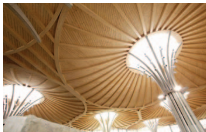
Bild 2 Dachkonstruktion Elefantenhaus Zoo Köln
