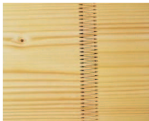
Bild 9 Keilzinkung in einer Brettschichtholzlamelle
